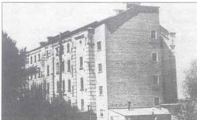
1949 г. Производственный корпус
